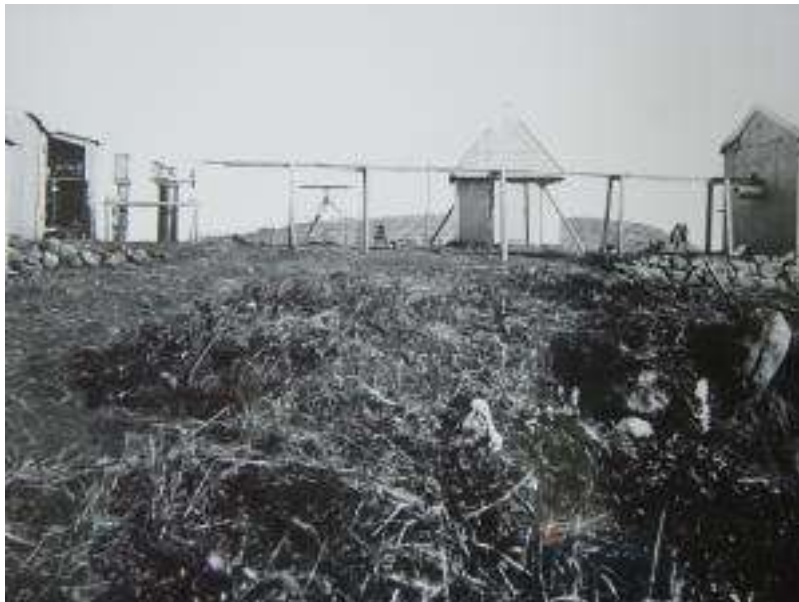
Obrázek č. 3: Stanoviště Nagasaki s heliografem z roku 1874, U. S. N. O. nemá žádné fotografie z let 1882). Na levé straně je vidět nosný sloup heliostatu: sluneční paprsky jsou vedeny pomocí zrcadel přes čočku a tubus do srubu, ve kterém se exponovaly fotografie (snímek U. S. Naval Observatory, laskavě zapůjčil Chuck Bueter).
