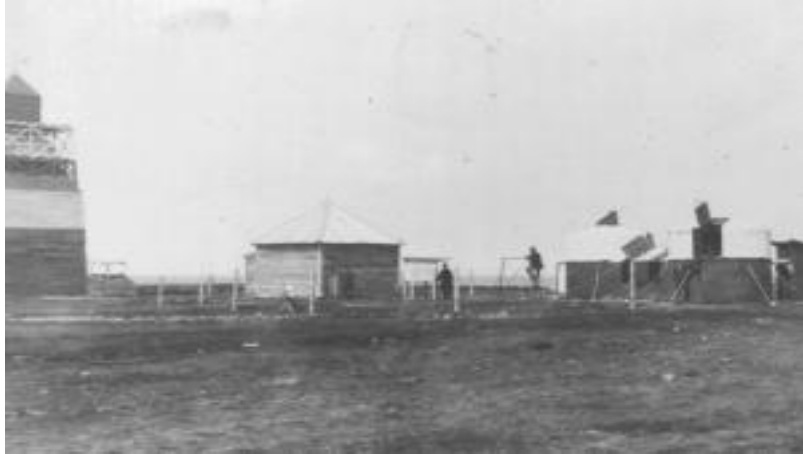
Obrázek č. 7: Fotografie německé stanice v Punta Arenas. Vlevo je vidět dřevěný maják na Punta Arenas, uprostřed čajovna a meteorologická stanice, vpravo dva pozorovací domky (železná konstrukce potažená plachtovinou) (Archiv, Berlin-Brandenburgische Akademie der Wissenschaften).
